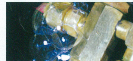
発泡液で漏えいを確認
